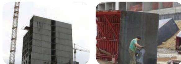
а) Нанесение краски непосредственно на поверхность из облицовочного бетона:
