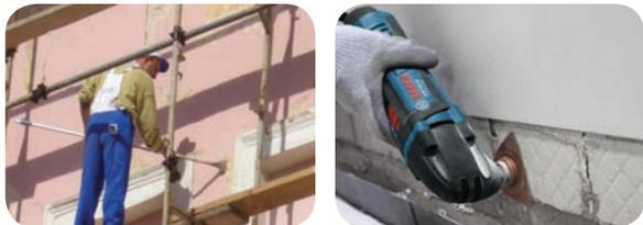
**ШЛИФОВАНИЕ:** Это процедура удаления от поверхности слабых слоев краски, шпаклевки и других материалов, и устранения неровностей поверхности и зубцов, выполняемая шлифовальными аппаратами, используя соответствующие виду поверхности насадки.
