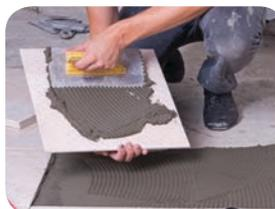
При устройстве керамических покрытий размерами более 20x20 см необходимо применять двухстороннюю адгезивную фиксацию (с нанесением материала как на поверхность, так и на тыльную сторону керамики), а также требуется увеличить размер зубцов.
