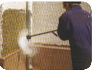
**SABLAREA:** Este procesul rezultat din sprayerea de materiale speciale numite nisipuri, care au aspect de nisip, dar sunt de fapt diferite de nisipul obișnuit și sunt special fabricate pentru această operăție. Nisipurile sunt de diverse tipuri siliciu, bazalt, arenit și se pot utiliza în locuri diverse, fiind suflate cu aer comprimat pe suprafețele care trebuie vopsite.
